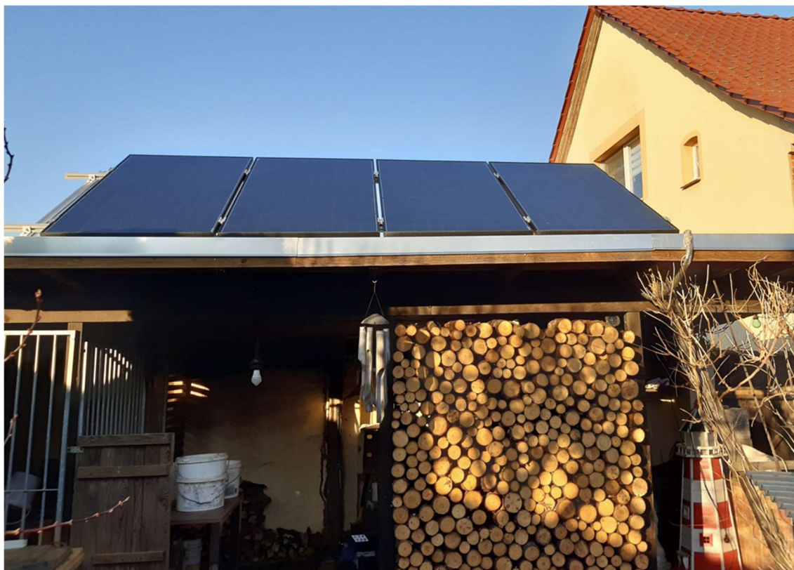
Bild 7: Nebengebäude 2 – Ansicht hofseitig
