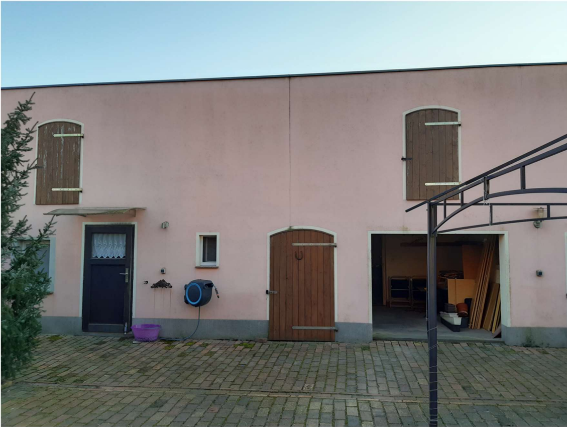
Bild 4: Nebengebäude 1 – Ansicht hofseitig
