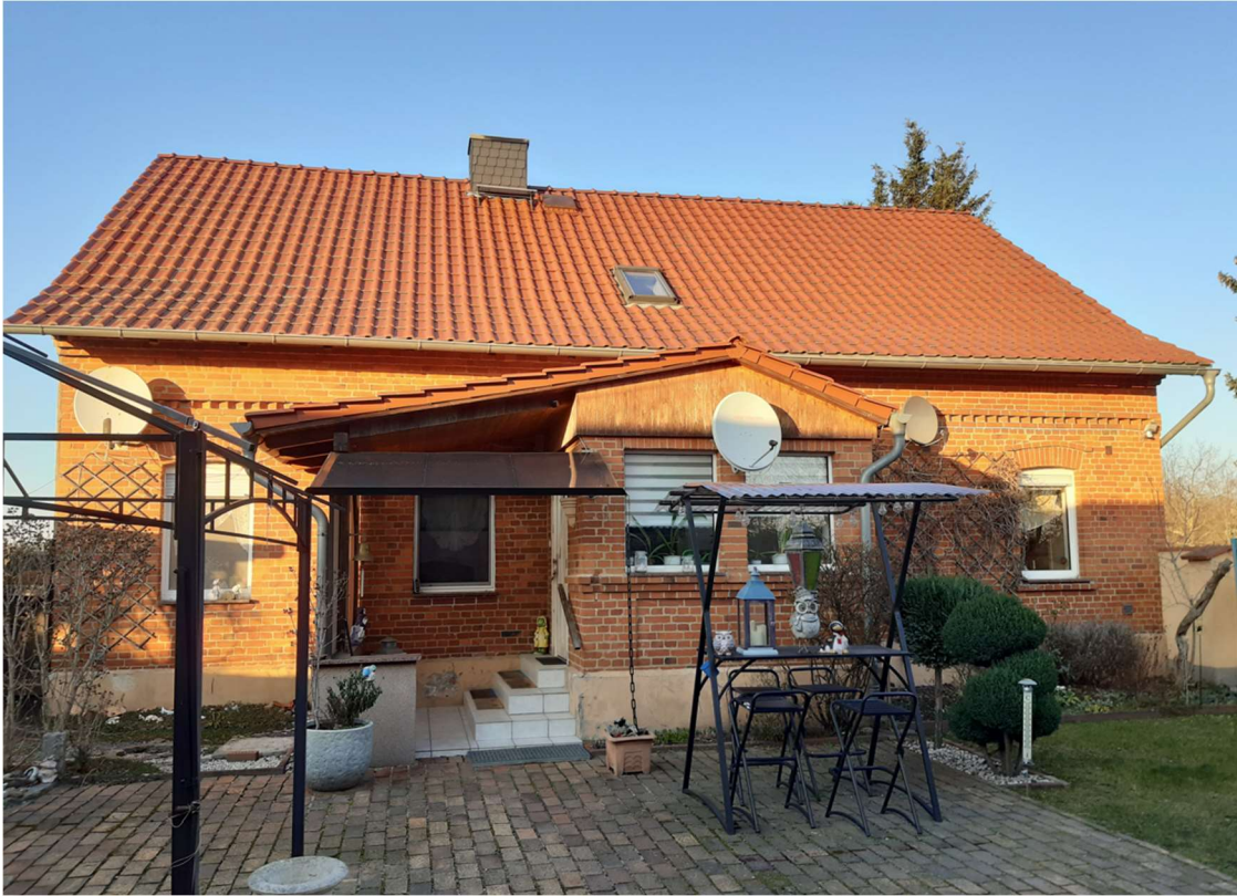
Bild 2: Wohnhaus – Ansicht hofseitig
