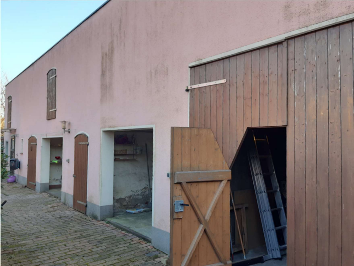
Bild 5: Nebengebäude 1 – Ansicht hofseitig
